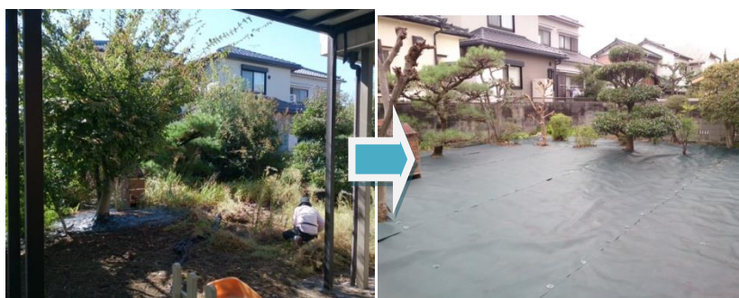
雑草回収防草マット工事
