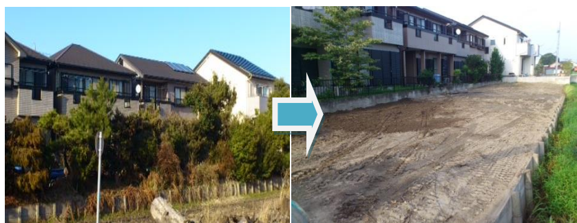
植木回収整地工事
