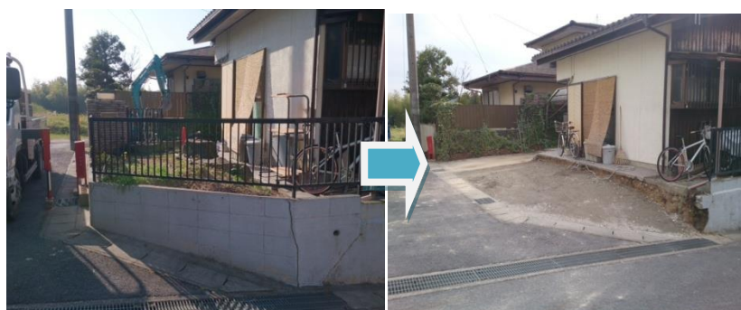
お庭改修工事（駐車場）
